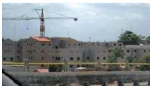
FIGURA 07. Obras do PAC – Rio Anil. Fonte: Arquivo da Pesquisa, 25/09/2008.
